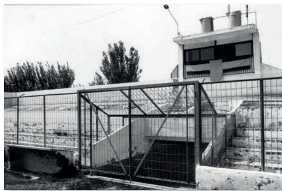
Las vallas metálicas se colocaron en el Estadio Municipal coincidiendo con la huelga del calzado. (Año 1977).
