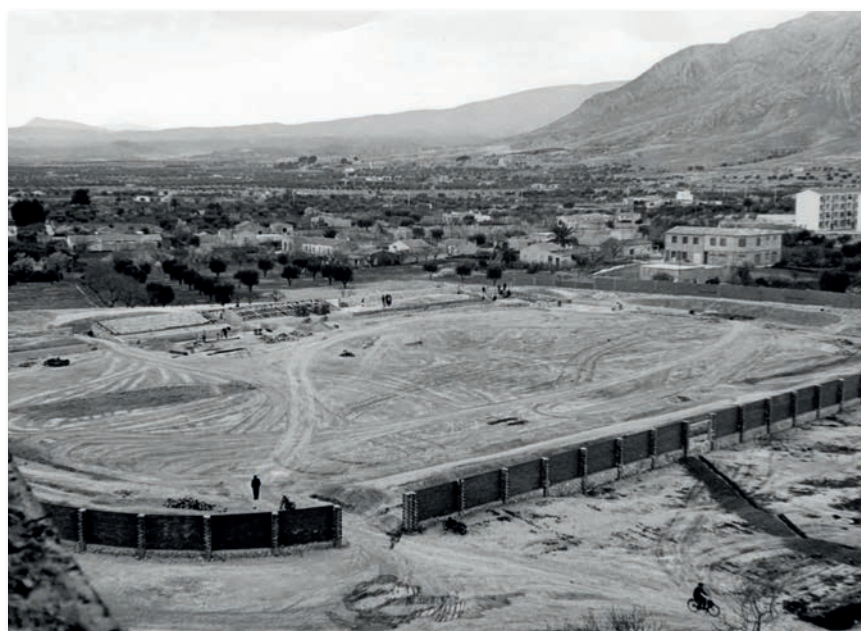
Recta final de los trabajos para construir el Estadio Municipal que vino a sustituir al campo de deportes El Parque, el 3 de marzo de 1964.
