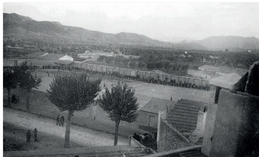
Vista panorámica del campo de deportes El Parque desde la avenida de Chapí. (Año 1930).
