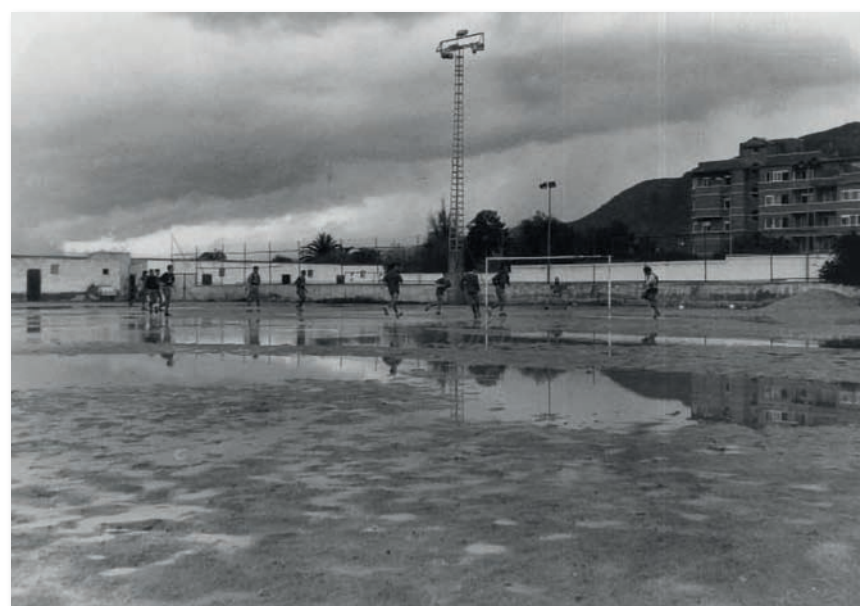
Imagen del Campo anexo al Estadio Municipal encharcado por su defectuoso drenaje (Año 1986).
