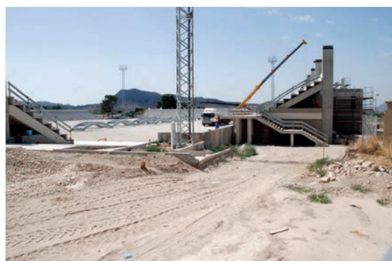
Trabajos de colocación de la tribuna cubierta en el Nuevo Pepico Amat, el 11 de julio de 2012.
