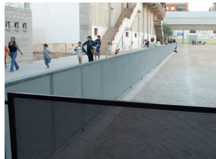
El Ayuntamiento de Elda terminó de cerrar el anexo con más vallas metálicas para evitar invasiones de campo. (Año 2004).
