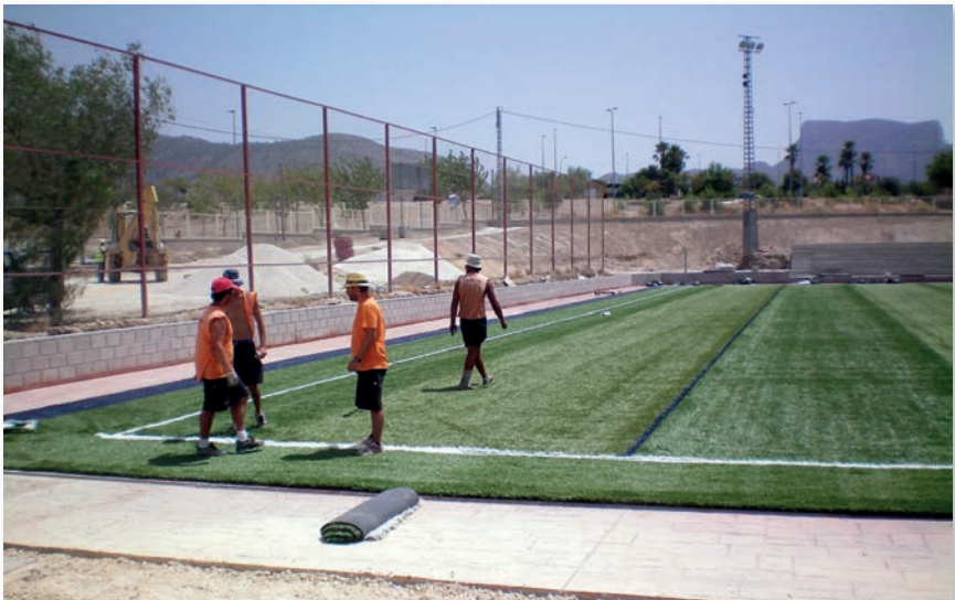
Trabajos de colocación del césped artificial en los campos municipales de La Sismat, el 22 de junio de 2009.
