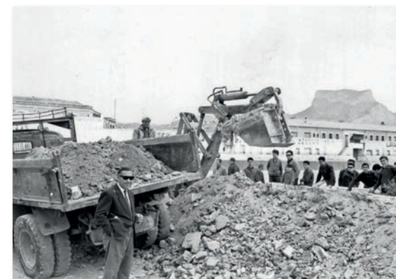
Las excavadoras comenzaron a derribar el campo de deportes El Parque el lunes 30 de marzo de 1964.
