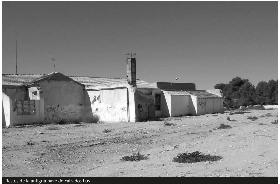
Restos de la antigua nave de calzados Luvi.
