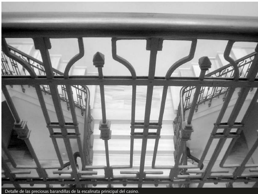
Detalle de las preciosas barandillas de la escalinata principal del casino.
