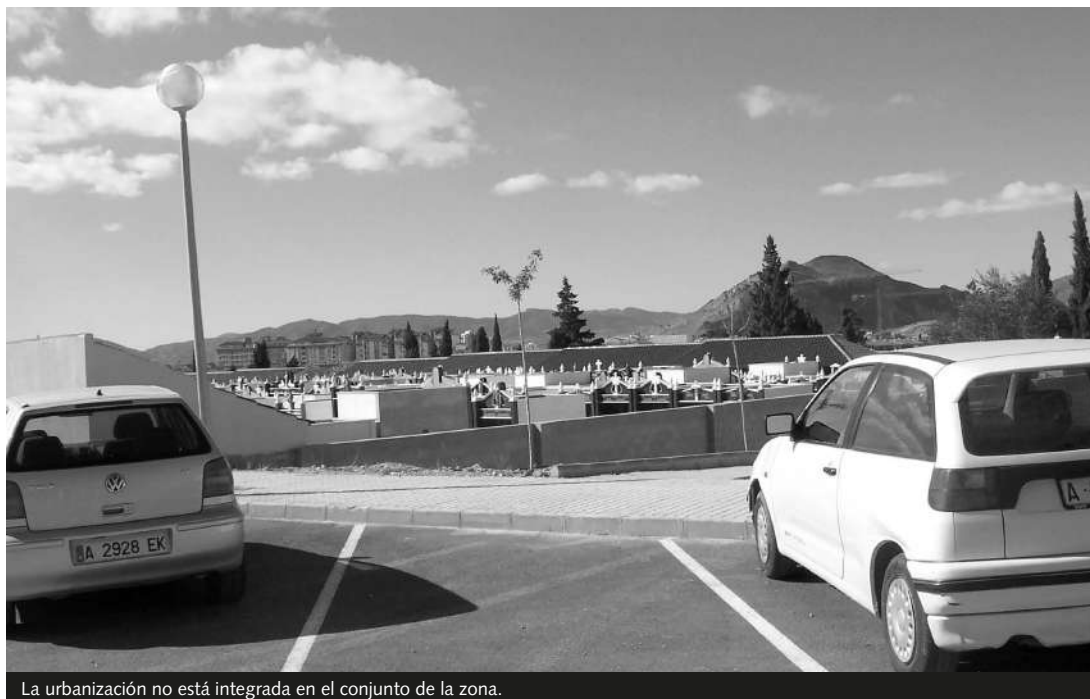
La urbanización no está integrada en el conjunto de la zona.
