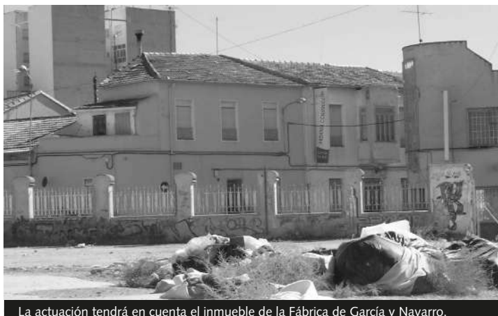
La actuación tendrá en cuenta el inmueble de la Fábrica de García y Navarro.
