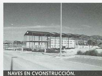
NAVES EN CONSTRUCCIÓN.
