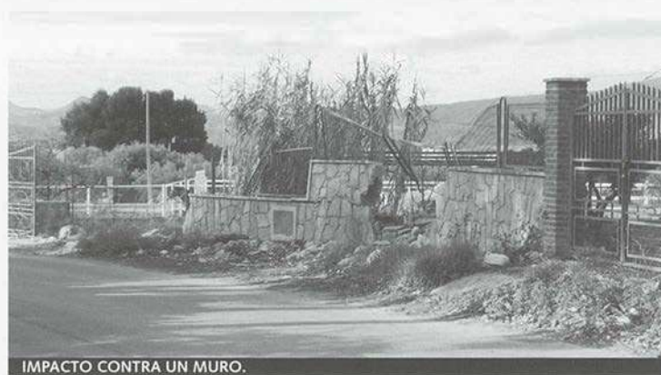
IMPACTO CONTRA UN MURO.
