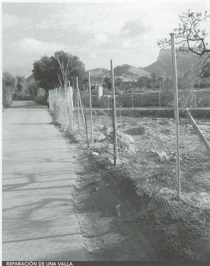
REPARACIÓN DE UNA VALLA.
