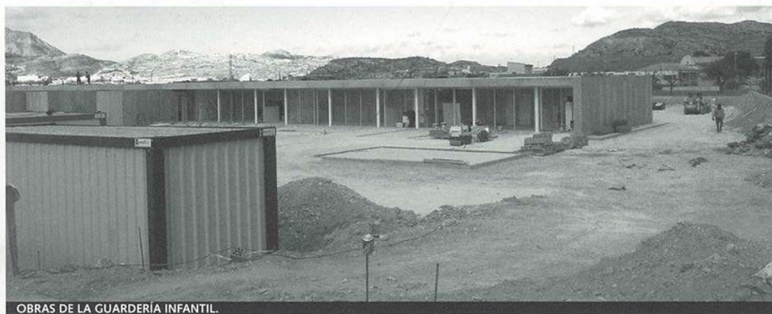
OBRAS DE LA GUARDERÍA INFANTIL.
