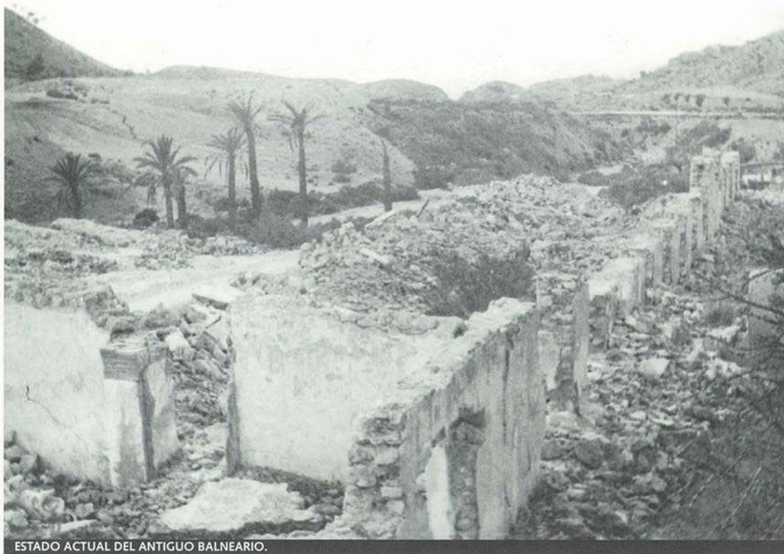
ESTADO ACTUAL DEL ANTIGUO BALNEARIO.
