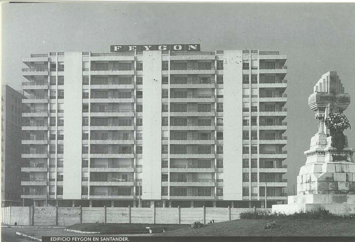
EDIFICIO FEYGON EN SANTANDER.
