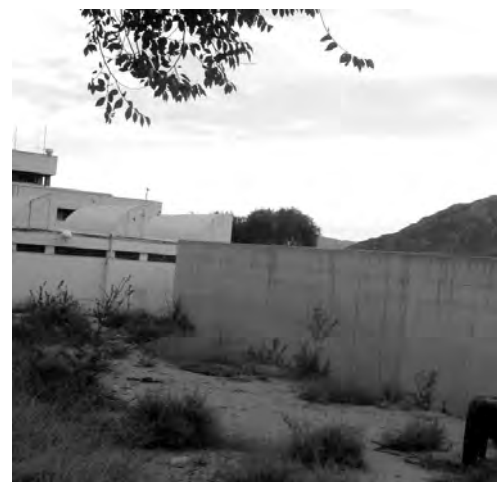
Las obras están paradas de nuevo
