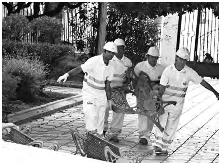
Las obras durarán aproximadamente seis meses
