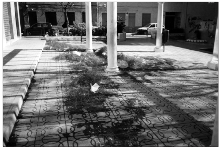
Estado en el que se encuentra una de las plazas de Elda
